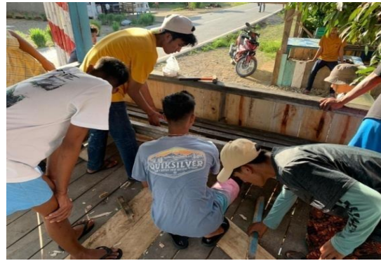
Gambar 12. Kondisi pemasangan papan
