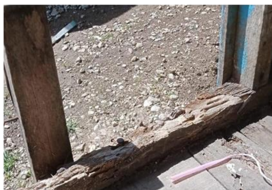
Gambar 8. Kondisi papan yang lapuk
