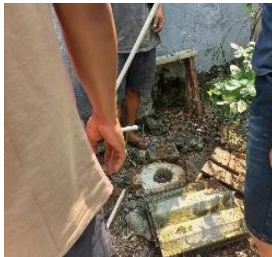
Gambar 3. Perbaikan Mesin Air
